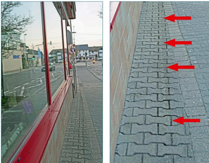
Bild 11: Verstärkte Frostschäden in besonders wasser-sättigten Teilflächen
