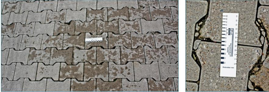
Bild 10: Frostschäden an »Wassersäufern«
