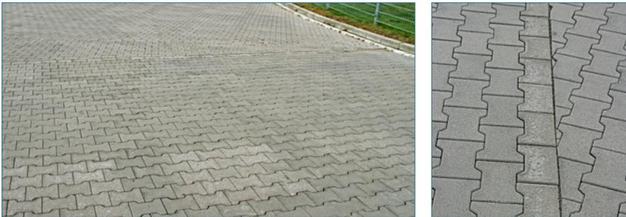
Bild 1: Durch Frost-Tausalz-Einwirkung verursachte Zementsteinabwitterungen an Betonpflastersteinen
